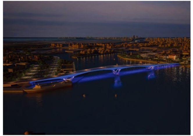
跨港大橋上將設有行人道、自行車牽引道與觀景平台，並以橋拱與橋側之光雕照明來點綴安平港夜景。
