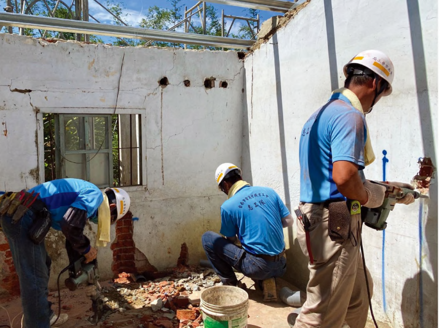
做工行善團集結各項專長的志工，共同改善弱勢民衆的居所，圖為電氣志工協助埋設管路。
