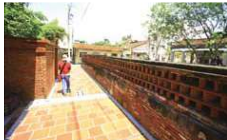
鋪面設計考量與橋南老街、王爺廟巷一致的意象，使用紅色陶磚與陶板。
