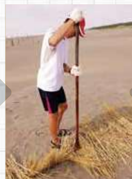
使用工具「土吐」將稻 稈的一端插入沙中
