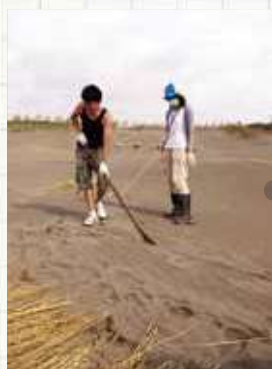
劃線，確定施作位置
