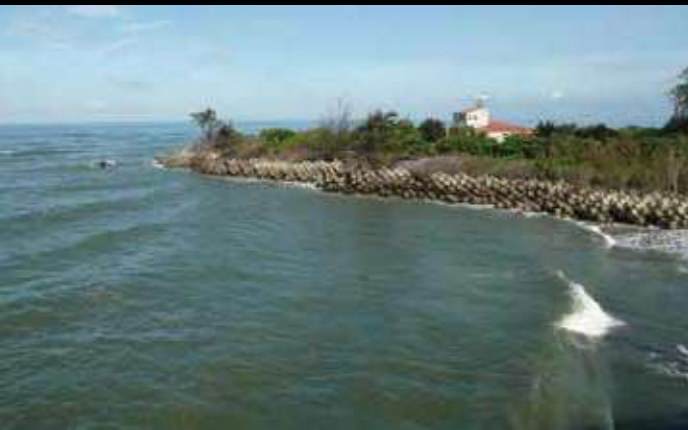
上下圖對照，可見海岸線陸移景況。沙洲、沙丘等都不見了，取而代之的是水泥製的防波堤。
