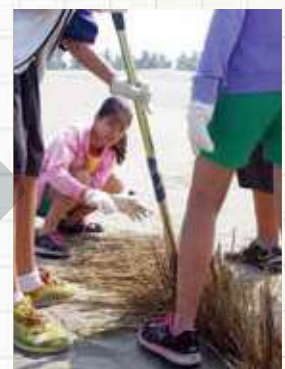
用雙腳收攏沙堆， 將已經插入沙中的 稻稈固定的更紮實
