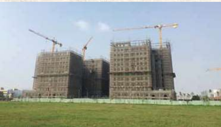
興建中的照顧住宅，預計106年年底完工。
