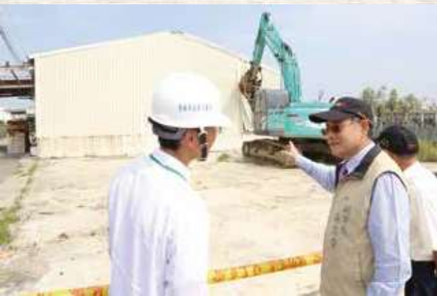
仁德段地上物拆除與清運工程現場
