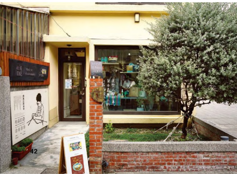
「社區自造」小鋪外觀有如民宅，前身為舊司法宿舍。
