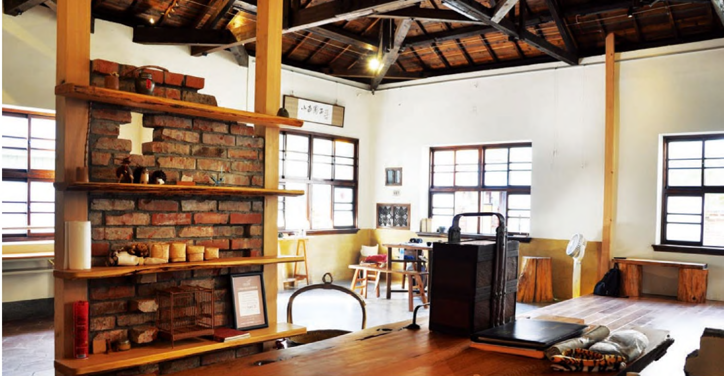
小南園子在修葺過程得以大幅保留原有建築結構，如磚牆、木構桁架屋架等。
