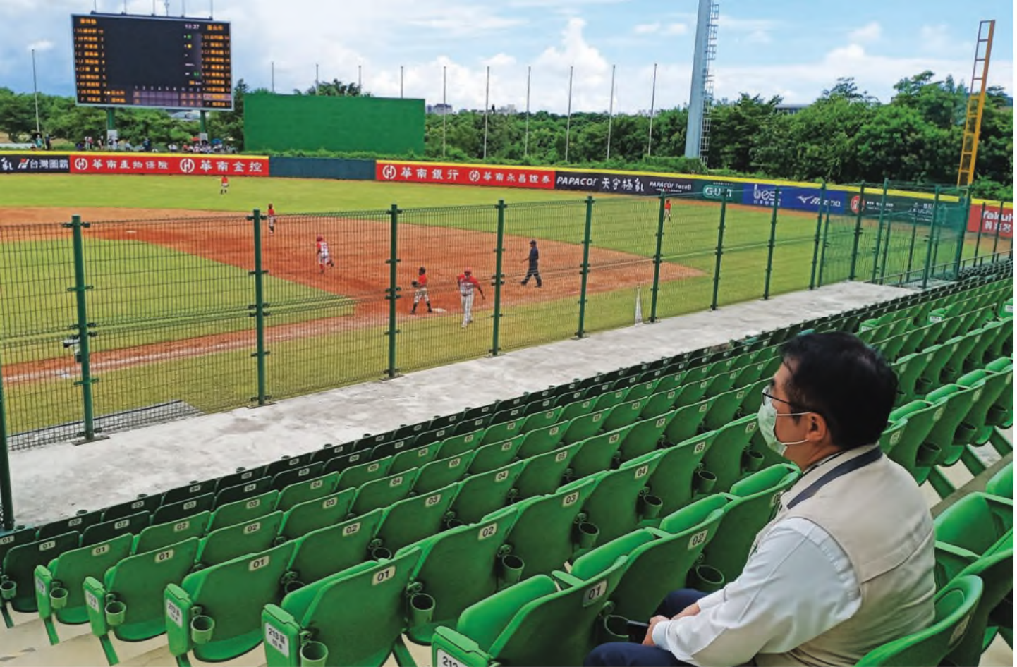
臺南亞太國際棒球訓練中心，第 1 期少棒球場完工啓用，讓第 5 屆 U-12 世界盃棒球錦標賽順利進行。
