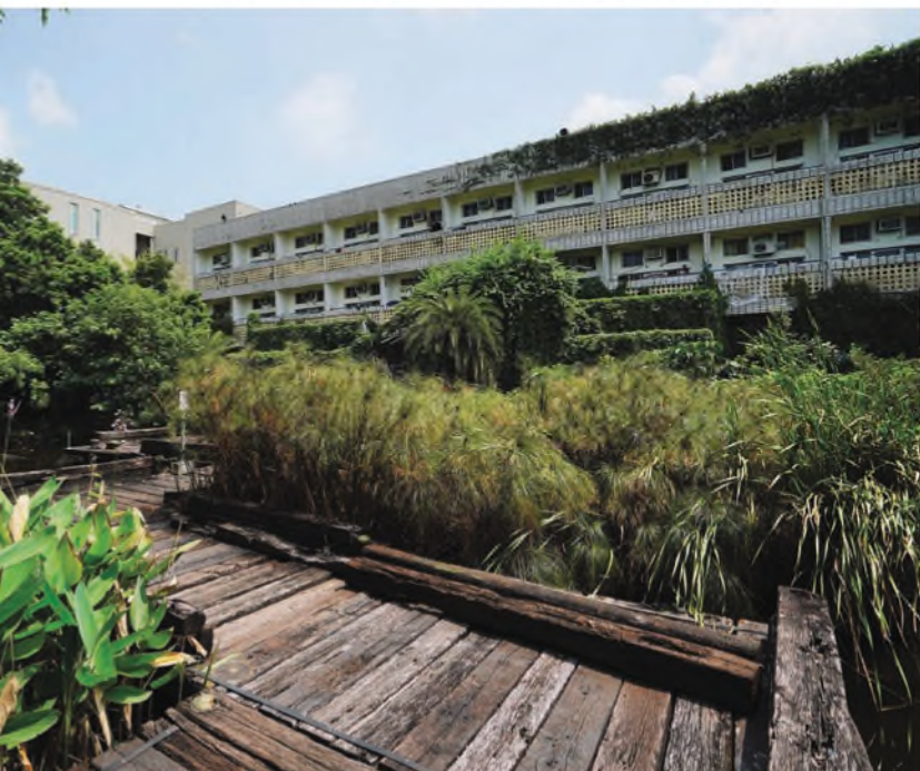
位於臺南市山上區的宏遠生態工業園，運用綠化、自然物理通風原理等綠建築工法，達到節能省電及降低溫室氣體排放的目的。
