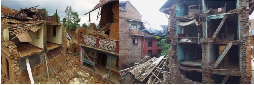
圖 8：受損房屋多屬耐震能力不足之建築
