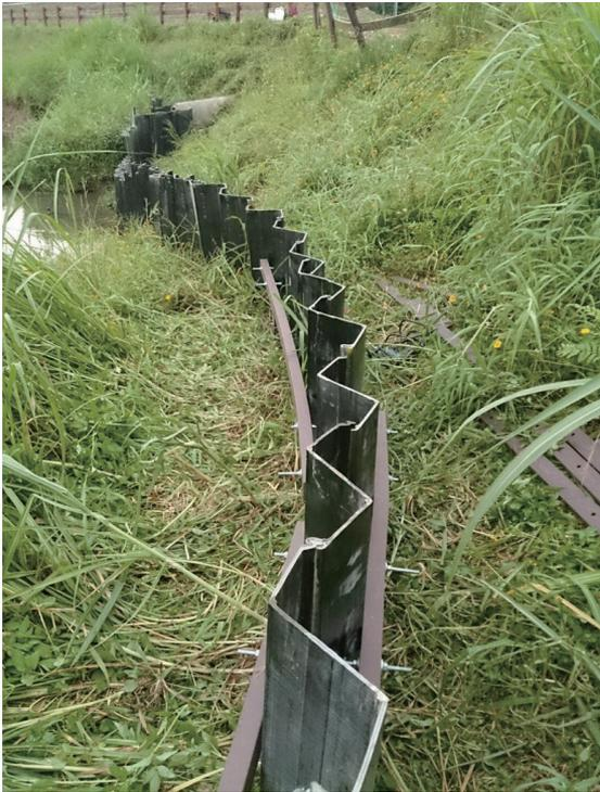
圖21 滴仔溝GFRP版樁打設完成照片
