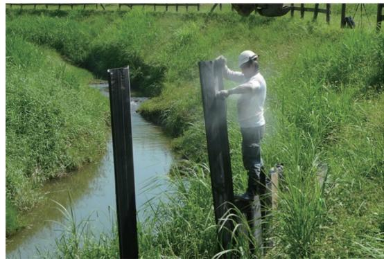
圖20 滿仔溝GFRP版樁現地裁切作業照片
