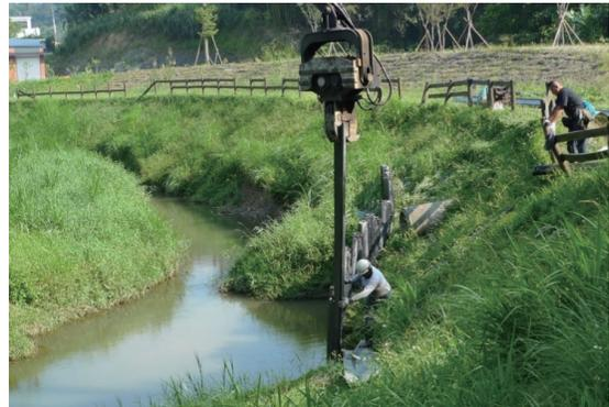
圖19 GFRP版樁安樁入樁與打樁照
