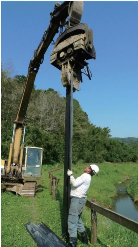
圖18 以人力搬運GFRP版樁嵌入震動打樁機夾頭照
