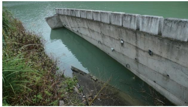
圖2 RC牆背側土壤遭淘刷照片
