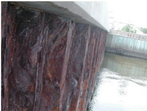
圖1 鋼版樁發生鏽蝕之照片
