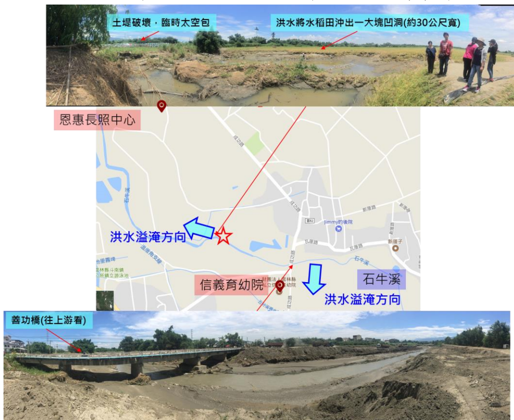
圖 15、石牛溪現勘與淹水分析 (照片來源：災防科技中心)
