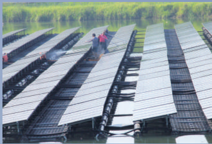
清洗滯洪池太陽能板。
