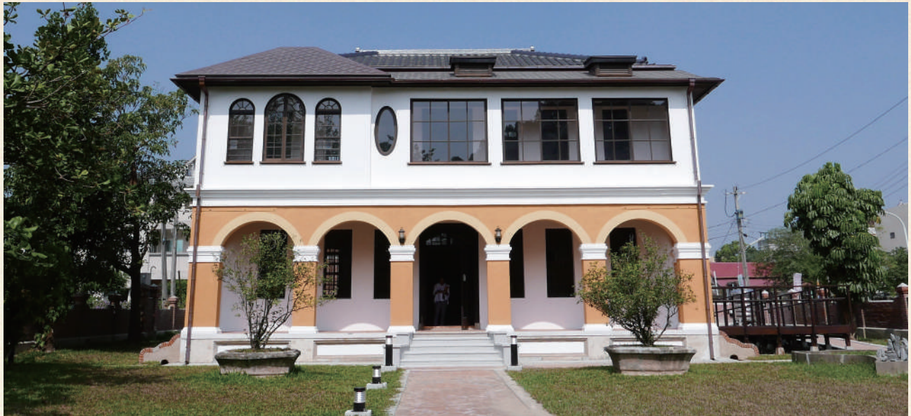
整修完工現況。
