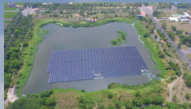
太陽能設施只會覆蓋滯洪池部份池面。 (照片提供/遠勁)
