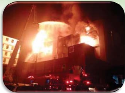
104/4/28 土城2廠火警事故 1人受傷 5-7樓層火警
