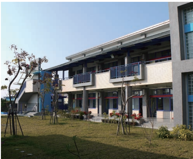
◎篤加國小甲仙地震校舍拆除重建工程
