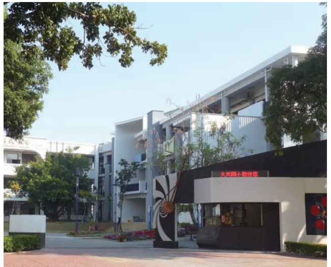
◎台南市大光國小南棟教室拆除重建工程
