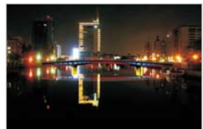
運河星鑽跨河橋樑(照片：公共工程處提供)
