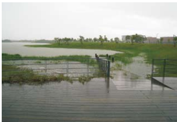
臺灣歷史博物館——滯洪池發揮了大雨滯洪之效
