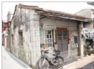
效忠街44巷1號改善前
