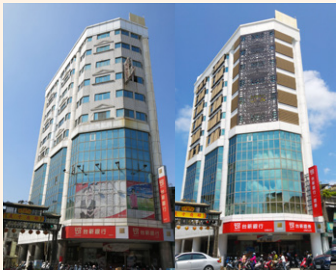
► 中西區西門財經大樓（更新前） ► 中西區西門財經大樓（更新後）
