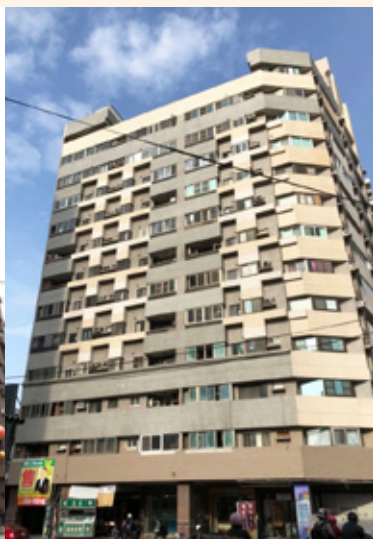
► 永康區嘉禧王朝大樓（更新後）
