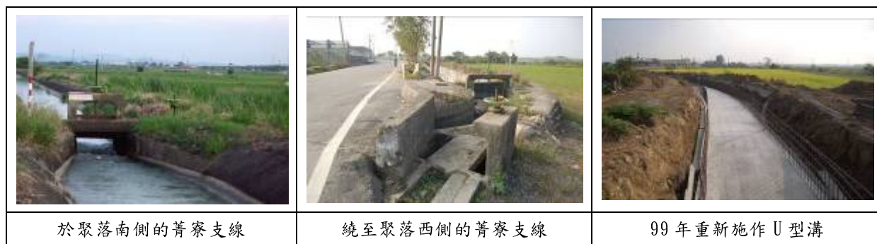
照片 4 臺南農田水利菁寮支線
