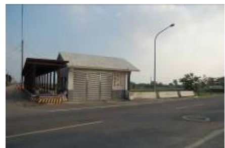
位於聚落南側南 85 線的抽水站
