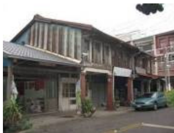
菁寮十字街區木造街屋
