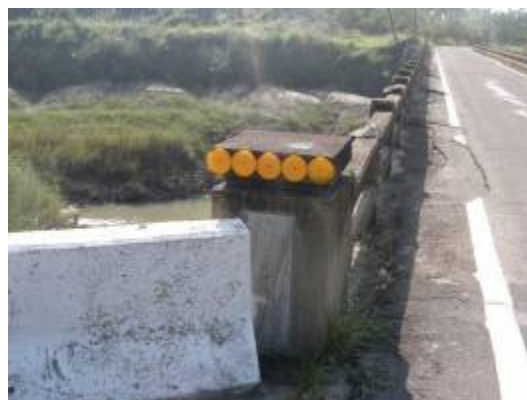
左鎮里的左鎮橋河床泥沙淤積，水流不暢，遇雨則淹橋面
