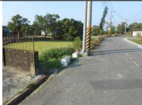
樹叔公對面埤塘安全設施
