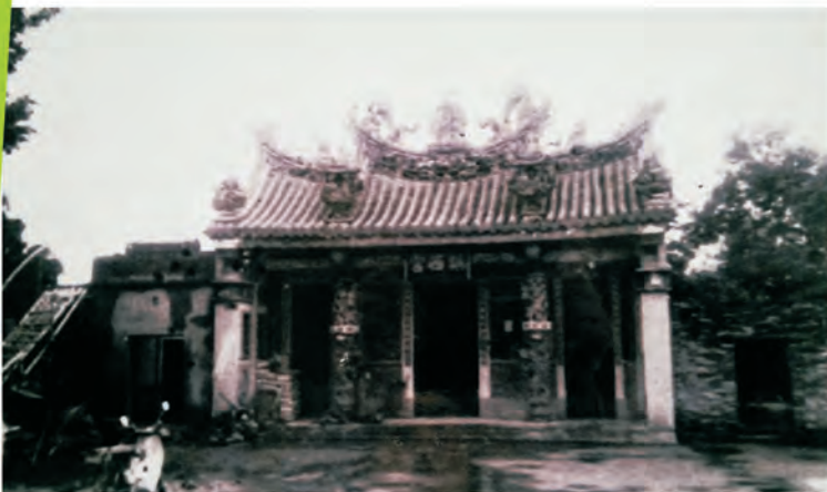
| 民國52年鎮西宮面貌(一) · 提供者/鎮西宮
