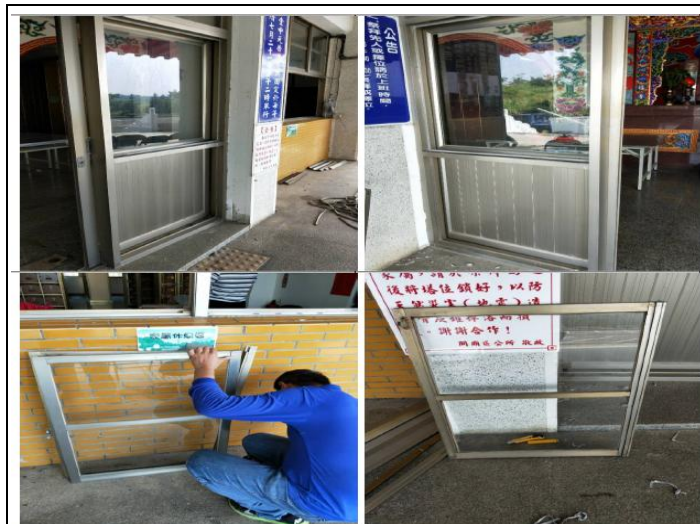
納骨堂 1.2.3 樓鋁門窗維修(維修前)
