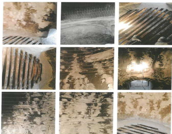
金爐修繕(施工後)
