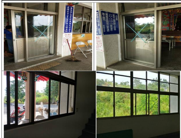
納骨堂 1.2.3 樓鋁門窗維修(維修後)
