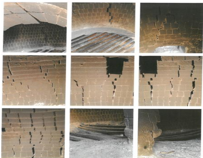
金爐修繕(施工前)
