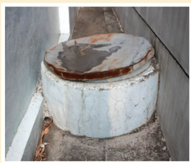
花園一街9號到11號之間的防火巷內的古井。
