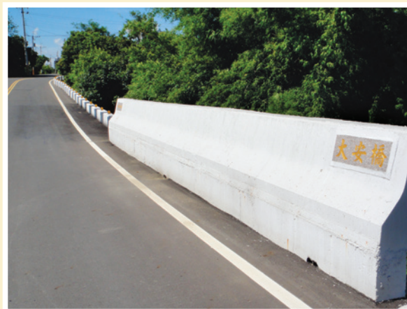
民國97年竣工的大安橋。
