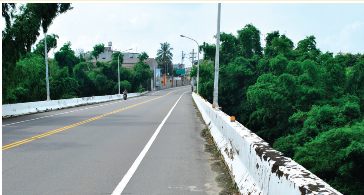
龜洞橋是龜洞村及田中村庄民往北，來往關廟市街非常重要的出入口。
