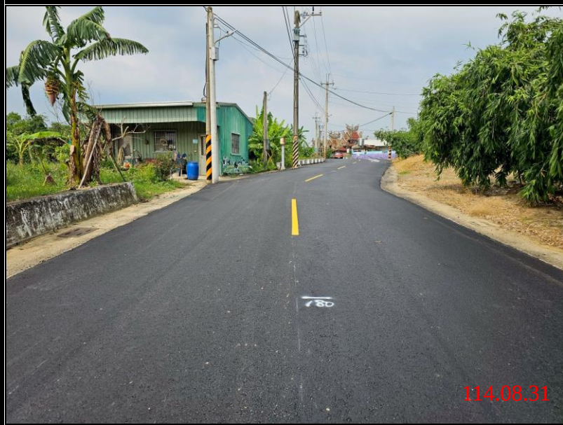
工區二 施工後
