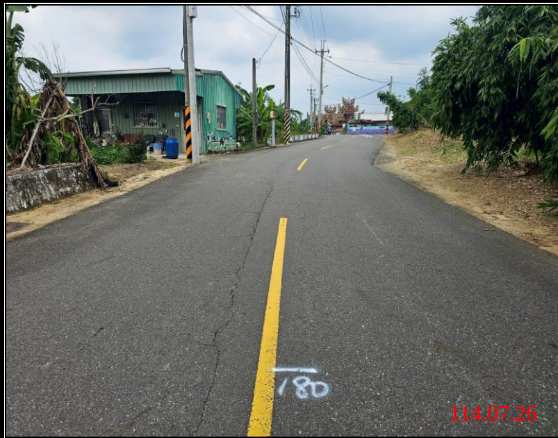
工區二 施工前
