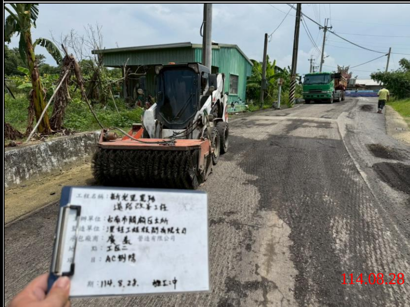
工區二 施工中
