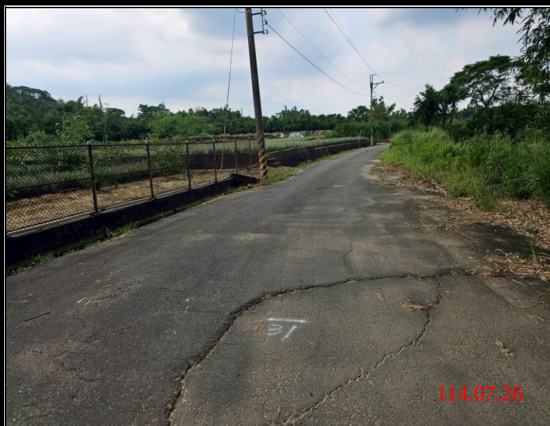
工區一 施工前
