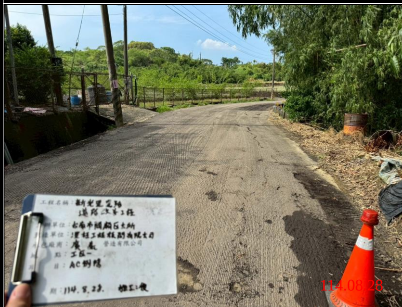
工區一 施工中
