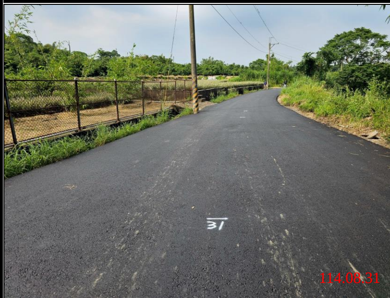
工區一 施工後
