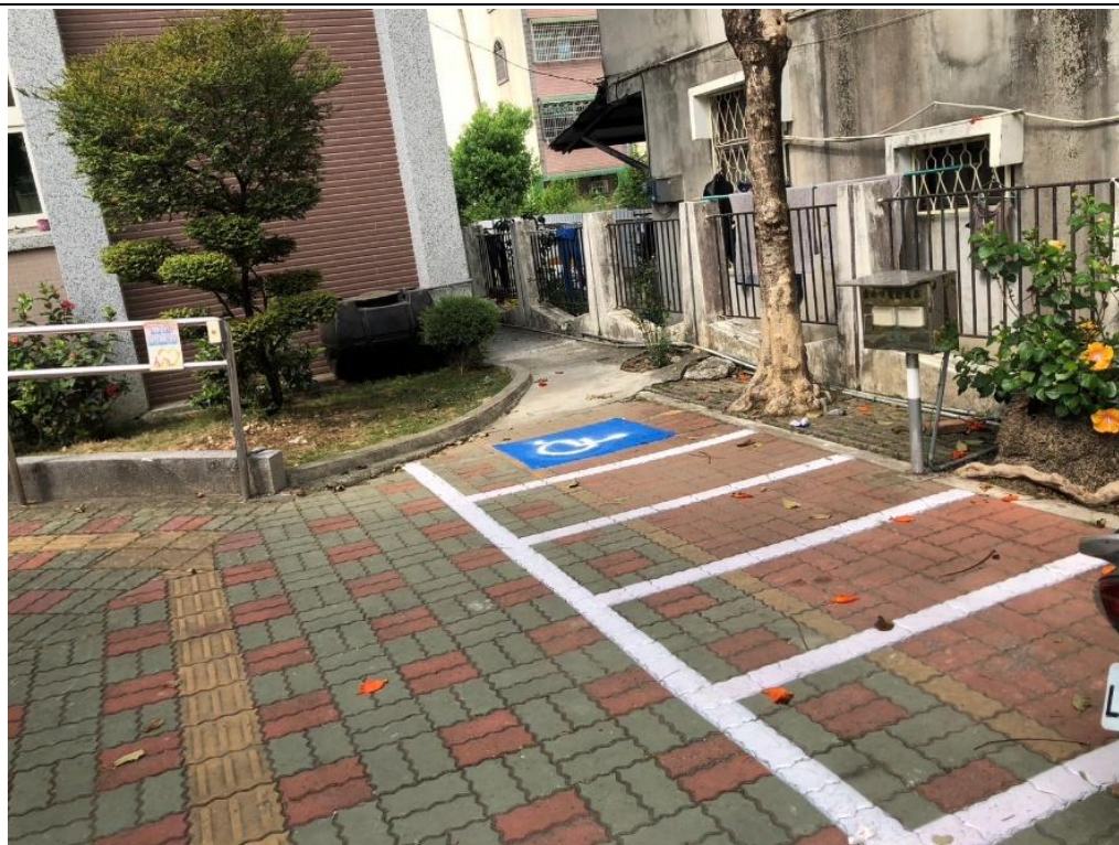
施工後-機車身障停車格
