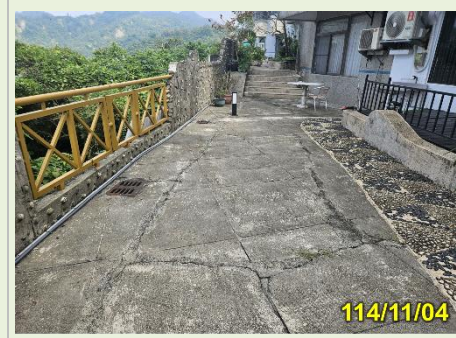
G 上邊坡社區內路面多有裂縫，具延續性，部分有陷落情形，裂縫寬度約 0.5~1cm
