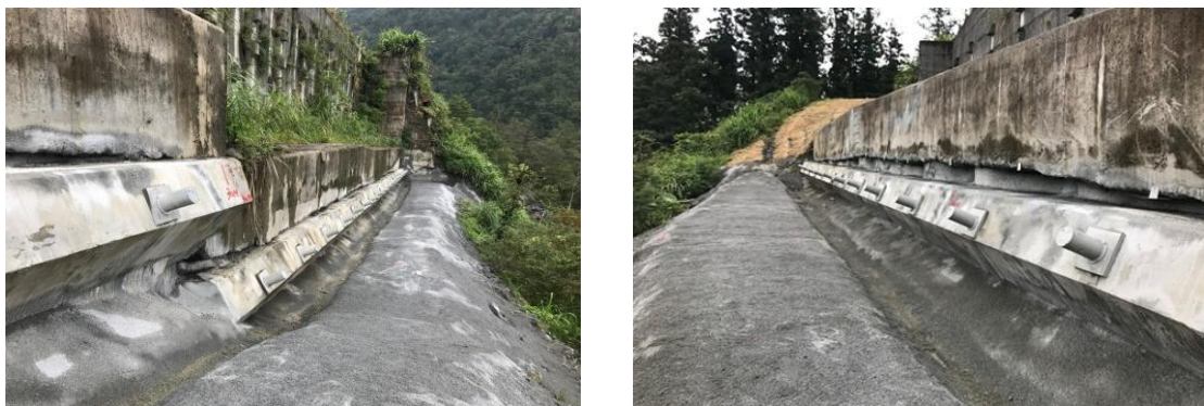
圖 3-72、下邊坡打設抗滑樁+地錨工法示意圖
