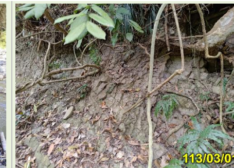
J 邊坡趾部可見高角度順向節理面出露
