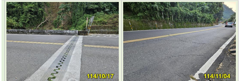
A 白水橋伸縮縫及護欄錯移，上游處邊坡崩塌 B 位於滑動塊體邊界道路裂縫持續擴大
