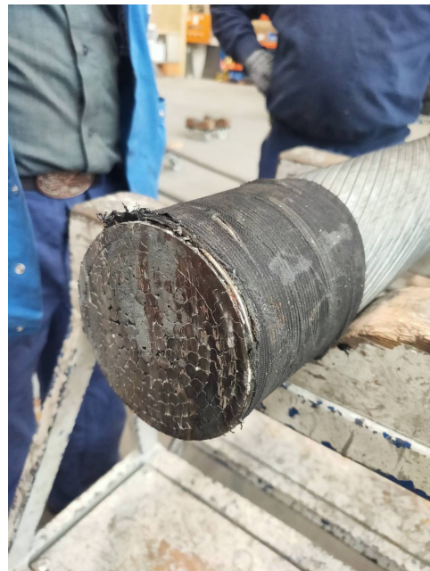
鋼纜斷面(鋼纜內圈係採用複層鍍鋅 平行鋼絲，外圈層採用單層Z型鋼絲)
