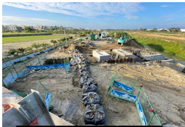
歸仁區媽廟橋旁既有箱涵改建工程
