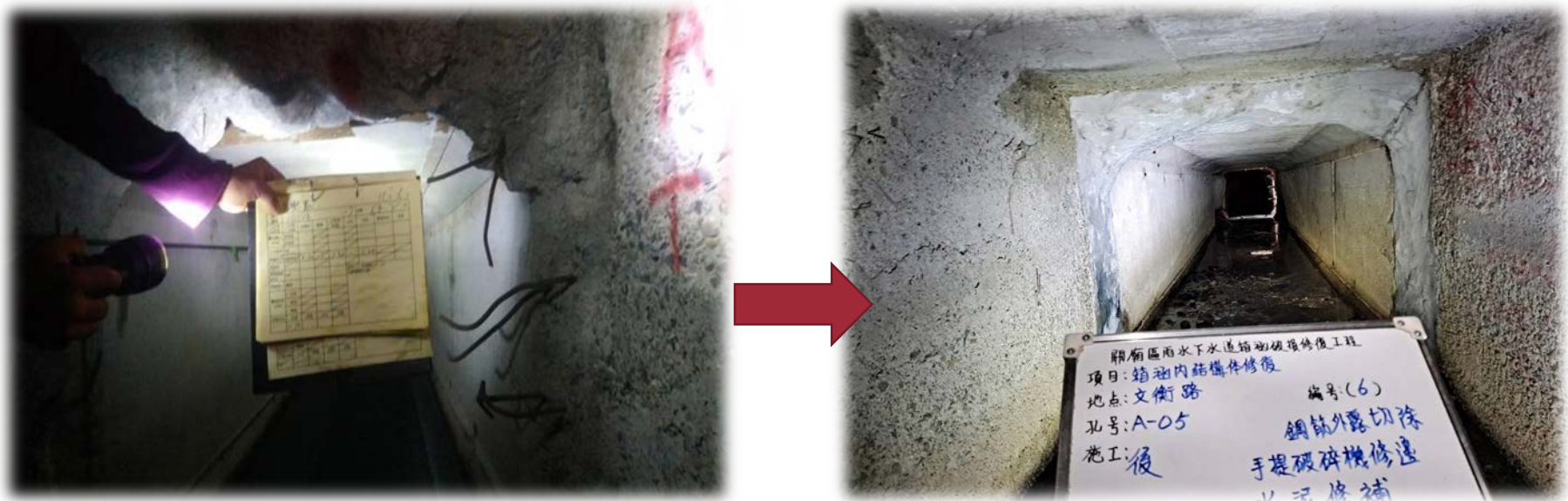
關廟區箱涵修補
