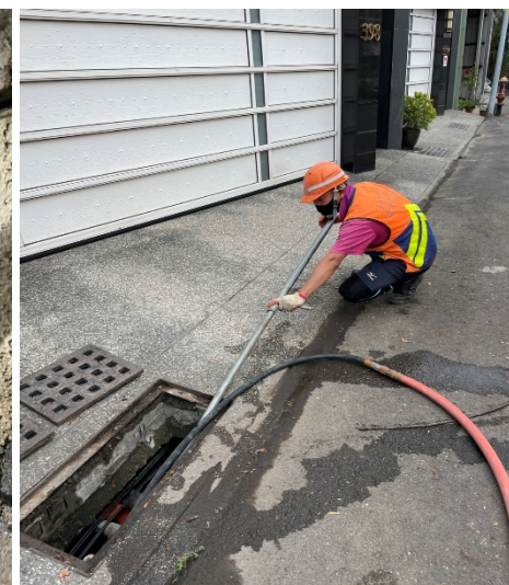
環保局安南區側溝疏濬
