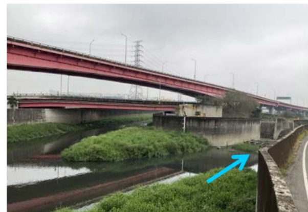
台南山上淨水廠下游送水管工程跨越新市排水水管橋
