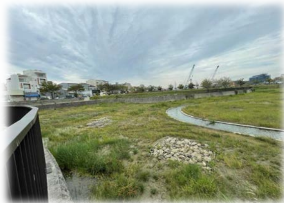
西灣里滯洪池
