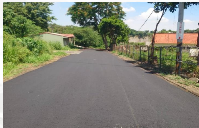
▲ 第一分營區柏油路面整修完成
