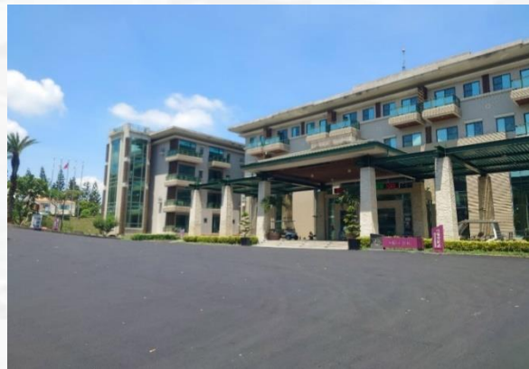
▲ 蘭花會館前柏油路面整修完成
