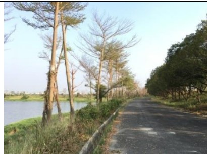
I. 港尾溝溪滯洪池道路
