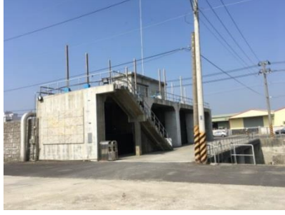
D. 港尾溝溪滯洪池入口通道 與港尾溝溪水門
