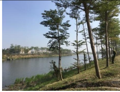
B. 港尾溝溪滯洪池現況
