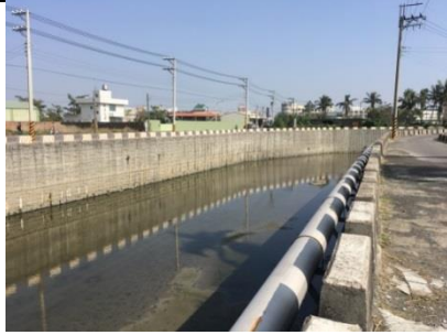
F. 港尾溝溪水道現況
