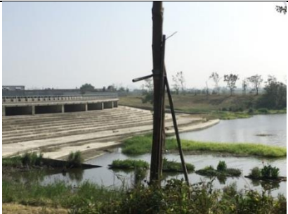
G. 港尾溝溪滯洪池溢流口
