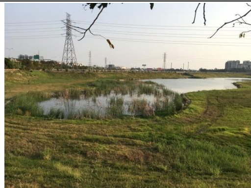
F. 仁德滯洪池(北池)
