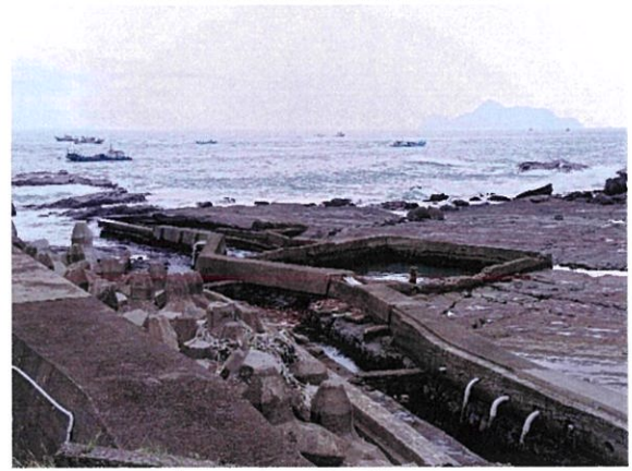
南防波堤外養殖池
