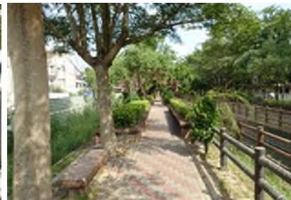
②南段嘉南大圳樹穴浮根嚴重
