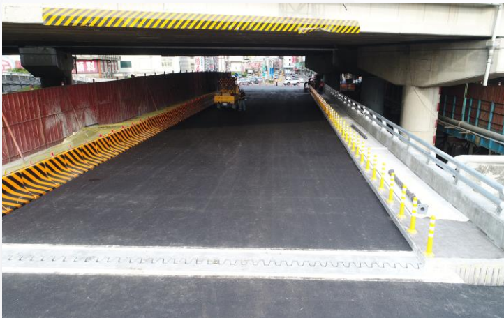
南側橋梁 完成
