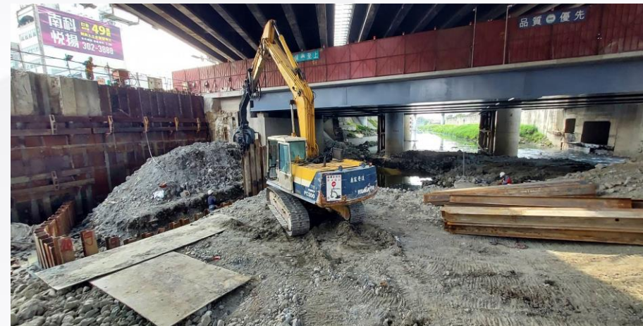
北側橋梁 基礎施作中
