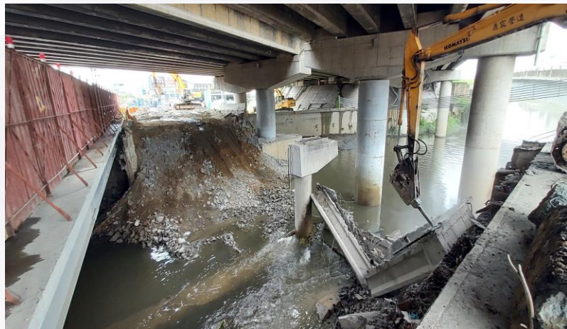
北側橋梁 拆除中
