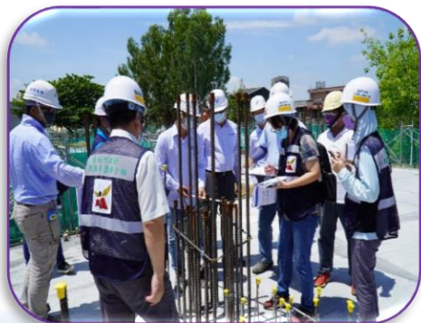
111.06.30 小新國小老舊校舍拆除新建工程
