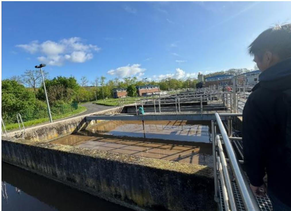
圖二、2-17.曝氣池沉砂池
