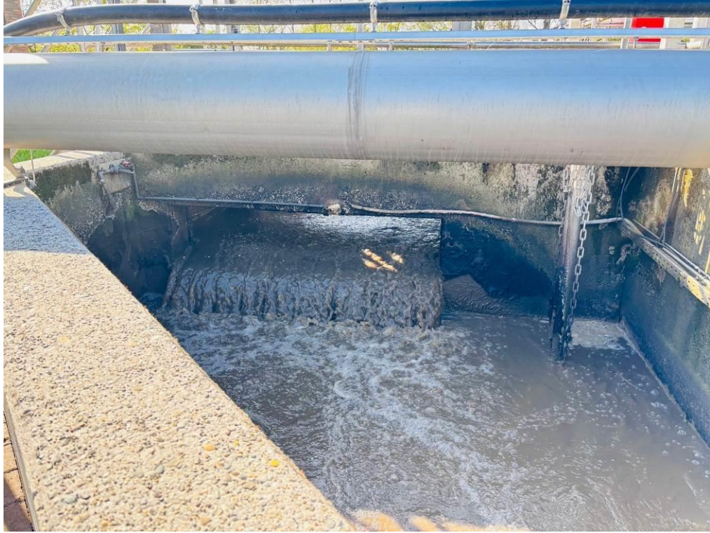
圖二、2-12. 進流渠道
