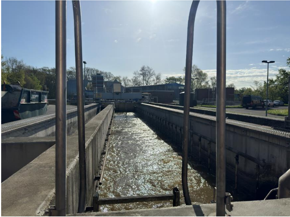
圖二、2-14.曝氣沉砂池
