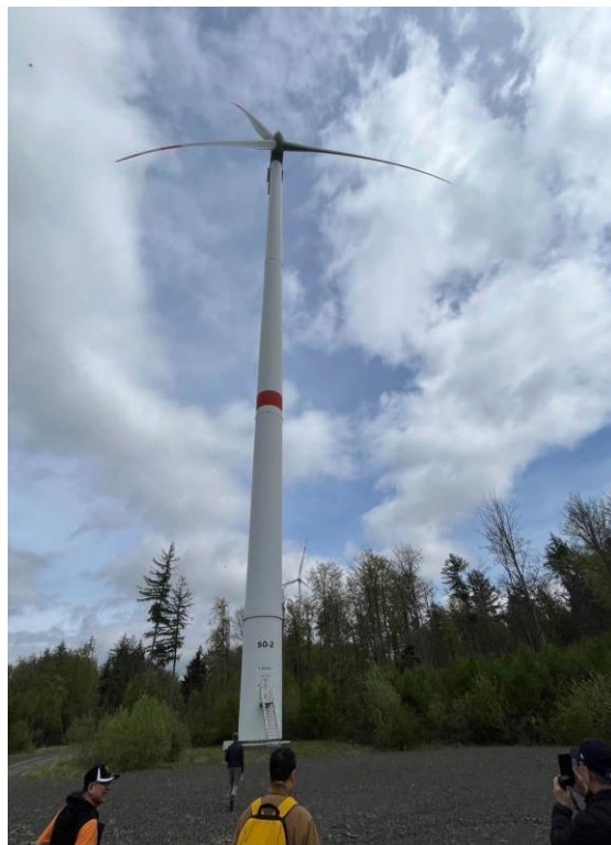
圖五、5-23. 風能設備
