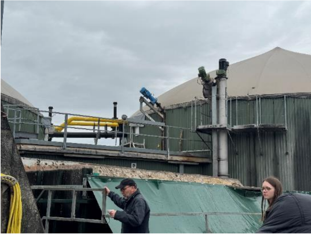
圖四、4-8. 進入消化槽前處理
