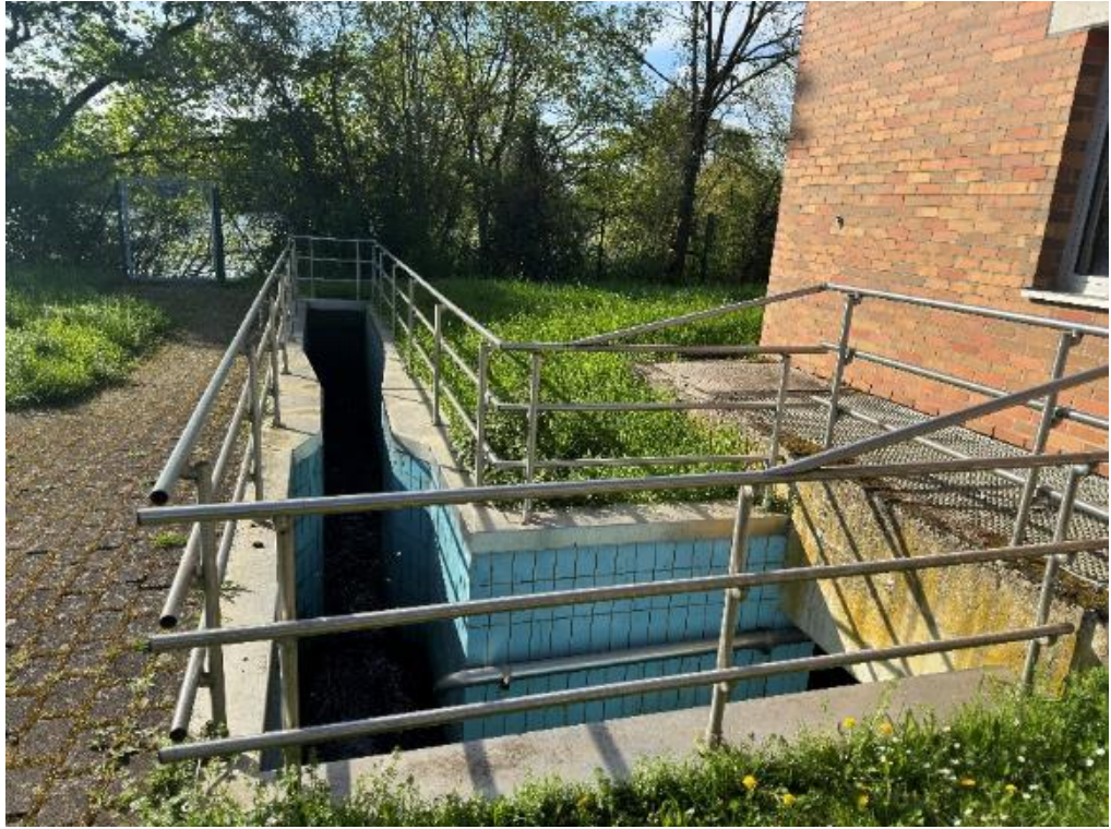
圖二、2-24. 放流渠道
