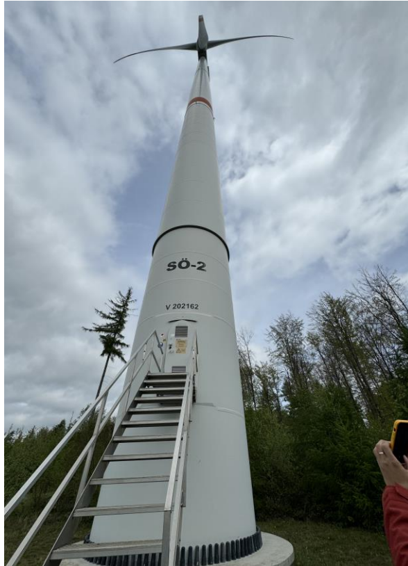
圖五、5-22. 風能設備
