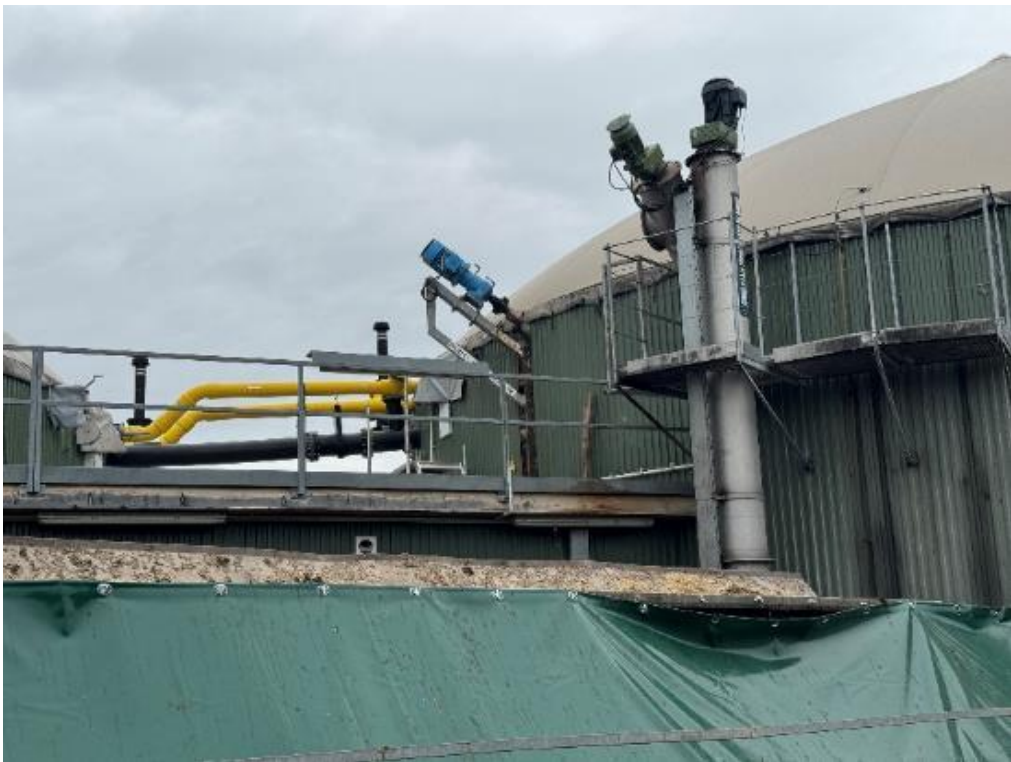
圖四、4-7. 進入消化槽前處理
