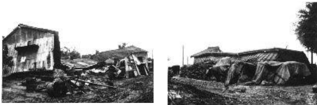
新營郡後壁庄(台南市後壁區)火車站前倉庫倒壞情形(根據台灣總督府氣象台,1942)
