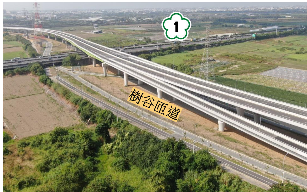
東工區(完工照片)
