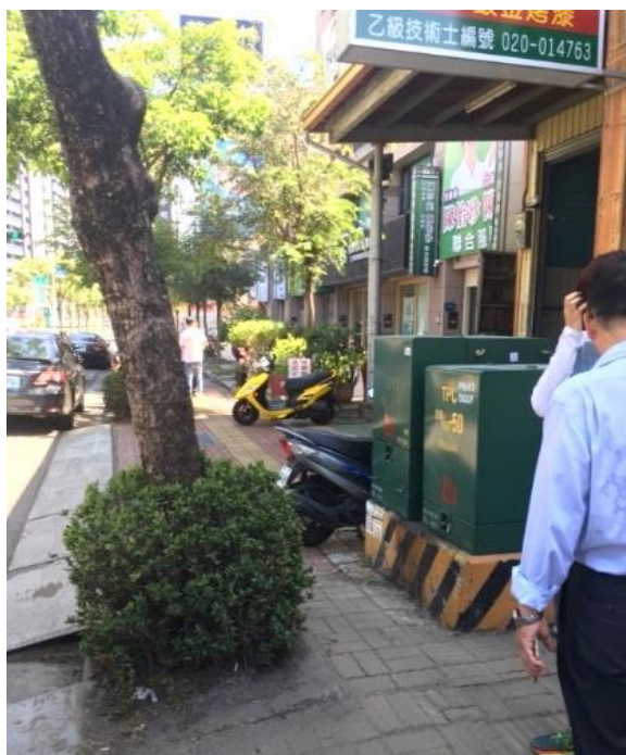
樹穴位置與電箱距離不足2米， 移除後將該樹穴封閉
