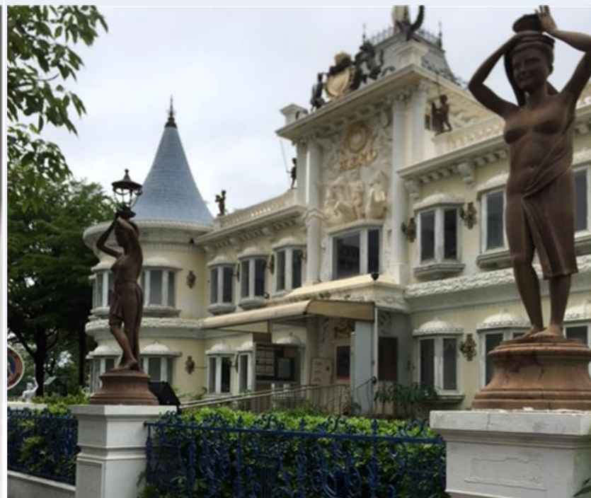
活化後(施工中)
