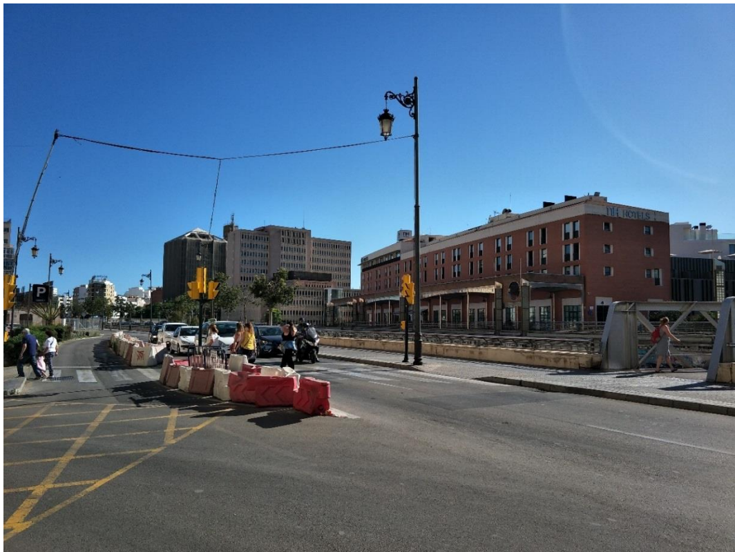
圖 6 馬拉加街景 施工防護措施
