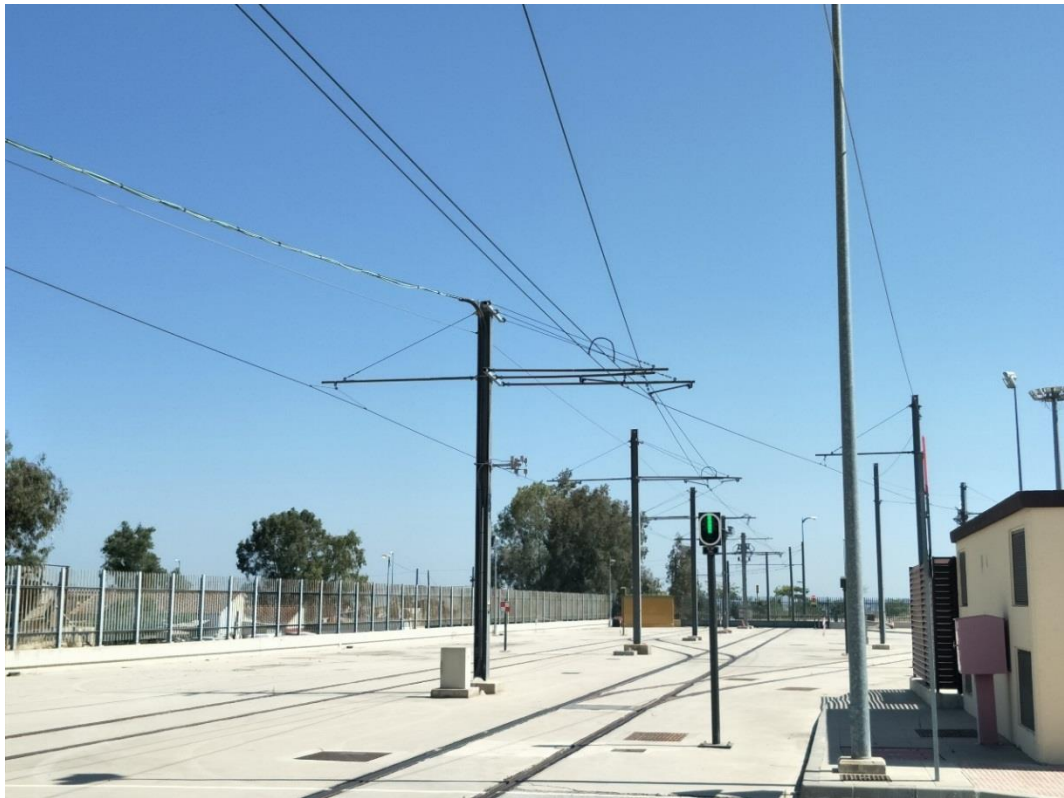
圖 42 西班牙卡夫輕軌是有電車線的，高雄是採超級電容
