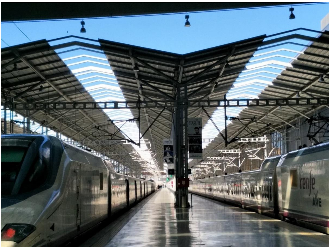
圖 32 馬拉加車站的高鐵月台，造型設有採光罩兼具採光功能
