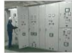
水再生センター・ポンプ所の設備再構築の調査状況(電気設備現況調査)
