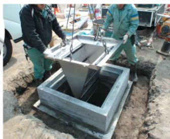
装置設置の施工状況
