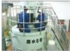
保全点検状況
