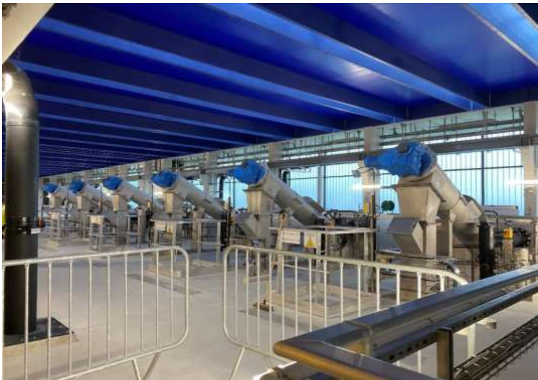
圖14 Achères Biosav 污水處理廠細篩機
