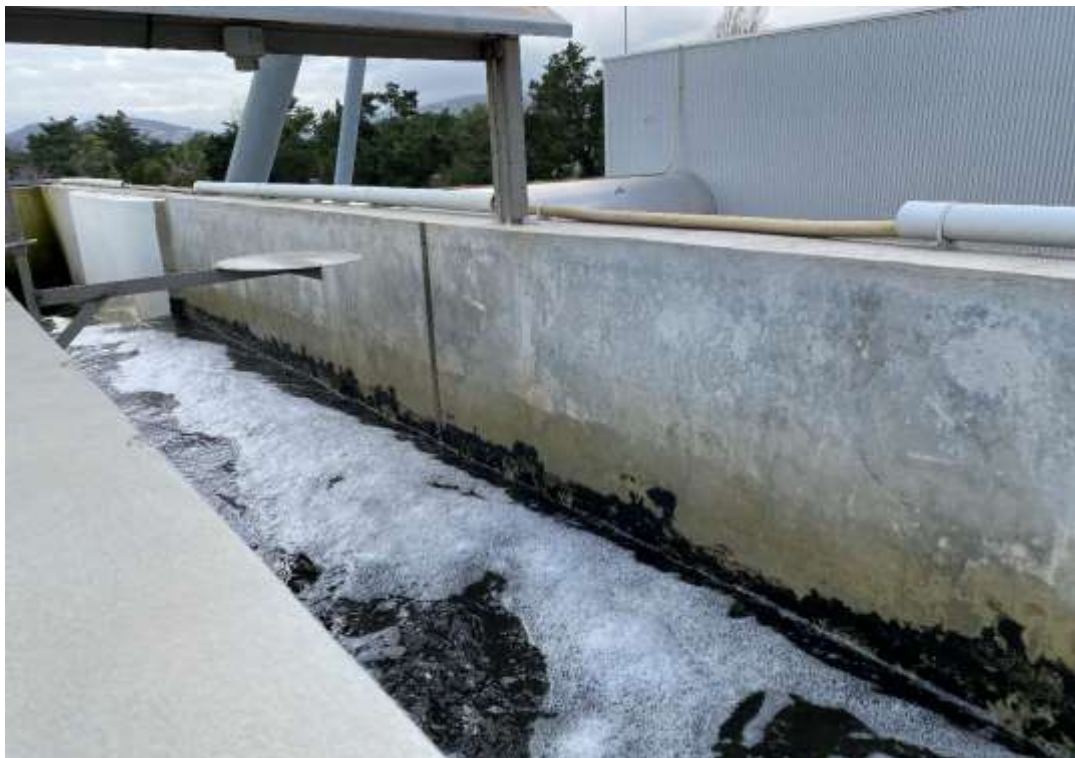
圖34 Aquaviva 污水處理廠放流水渠道
