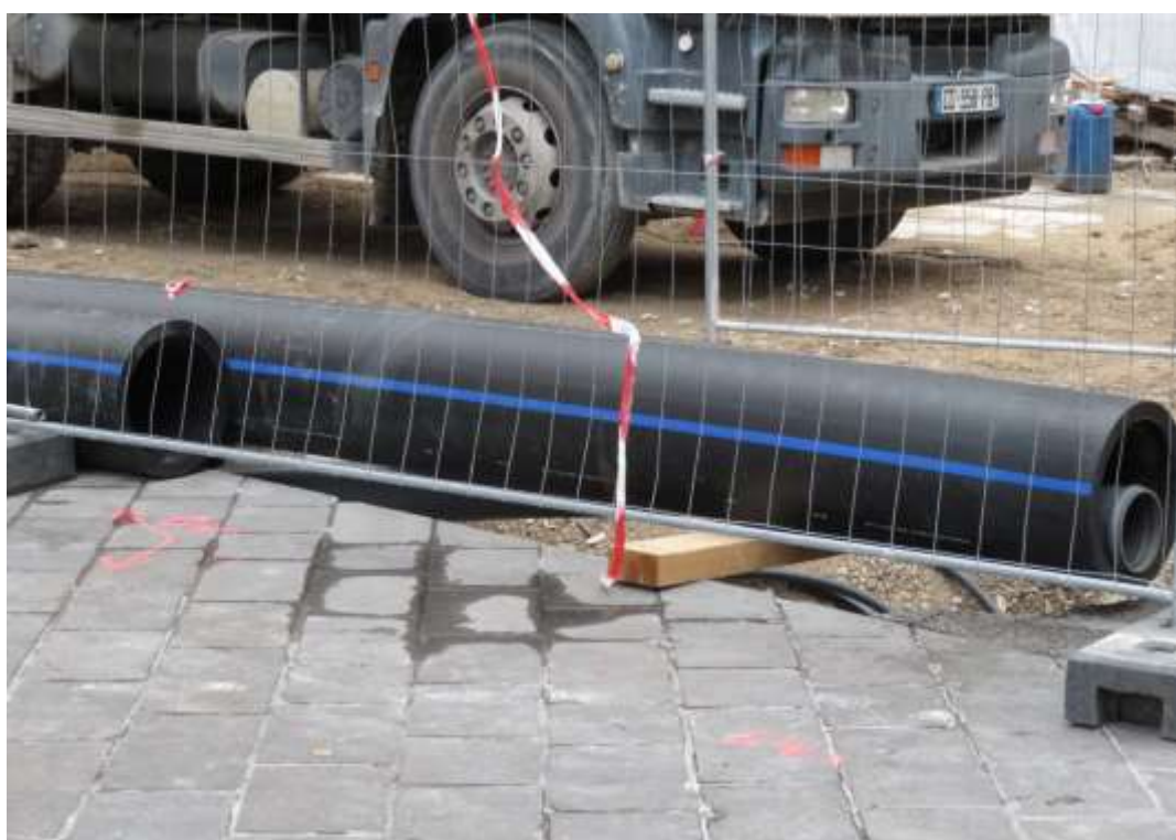
圖44 Grasse La Paoute MBR Plant 污水廠輸水管材
