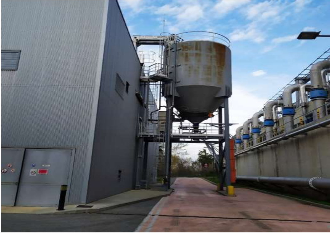
圖30 Aquaviva 污水處理廠活性污泥的除臭系統(1)
