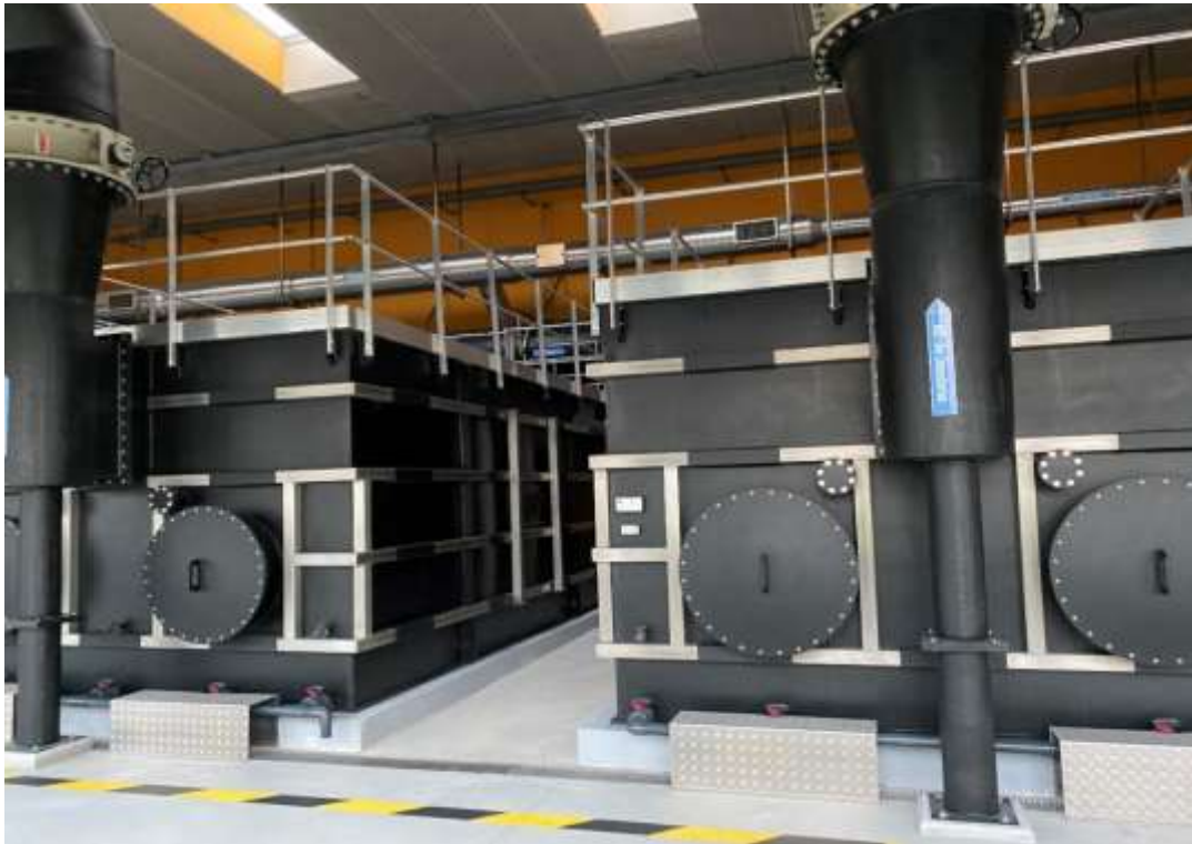
圖13 Achères Biosav 污水處理廠生物處理
