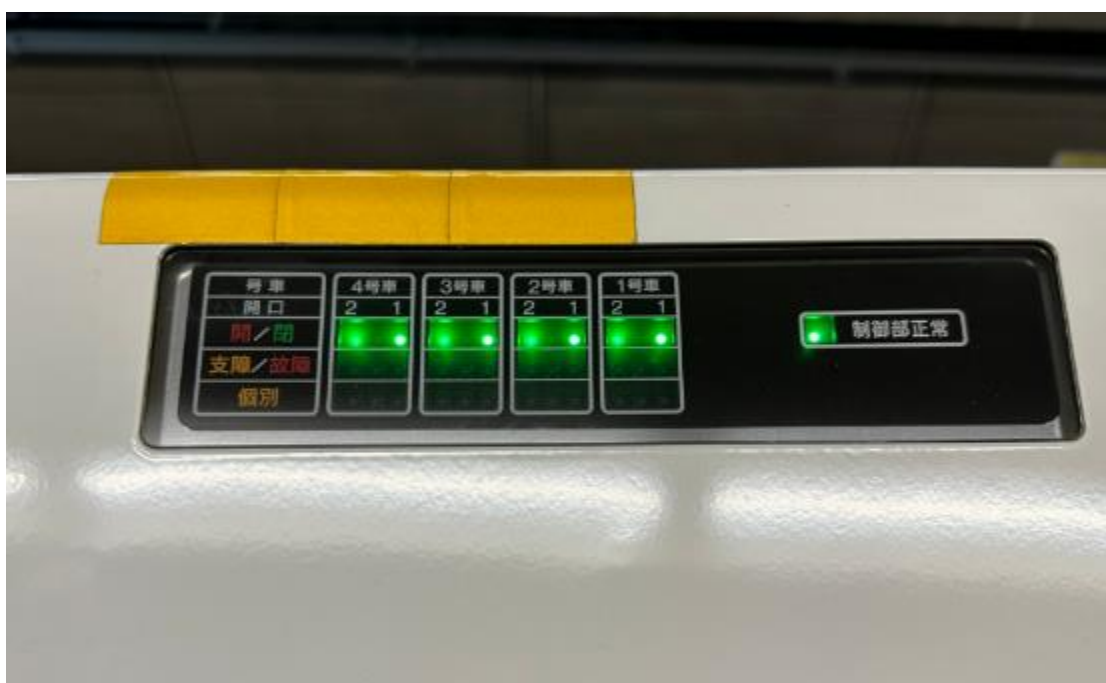
圖 60：月臺門設有狀態顯示器，清楚顯示月臺門狀態
