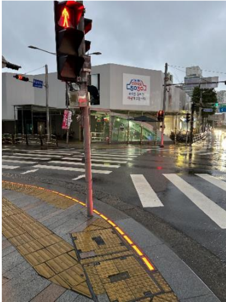
圖 46：部分路段人行道路緣設置燈光，提升用路安全
