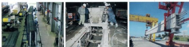
鉄筋の組み立て 型枠へのコンクリート打込み 型枠を外した軌道桁
