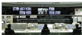
運輸指令室全貌 画面には、列車運行管理画面が表示されており、運行管理の状況を確認することができます。
