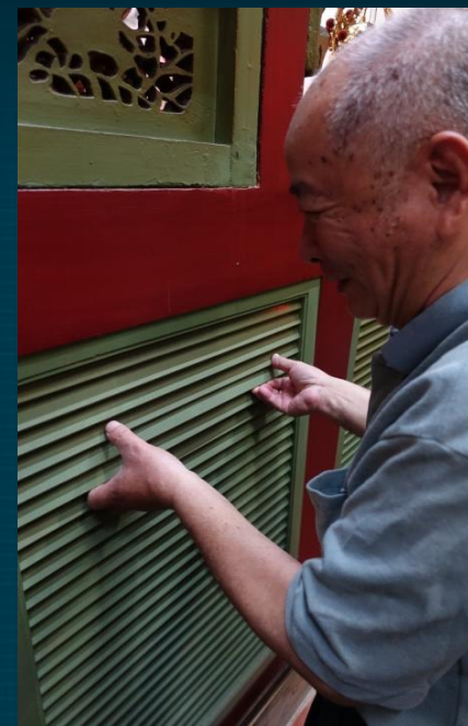
市定古蹟總趕宮 正殿神龕堵板氣窗新作
