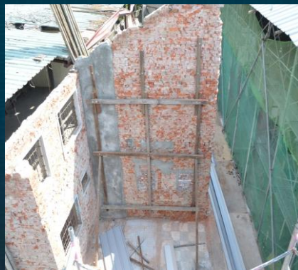
歷史建築原白金町 日式宿舍修復工程 磚牆緊急支撐
