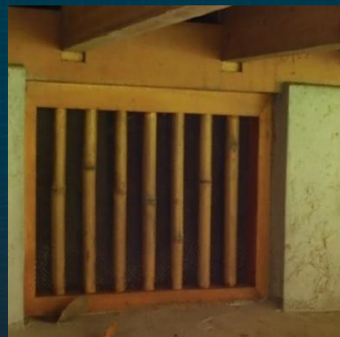
歷史建築原竹園町 臺南州職員宿舍修復工程
