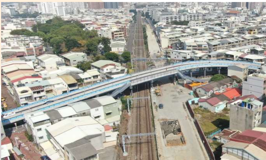
長榮臨時鋼便橋
