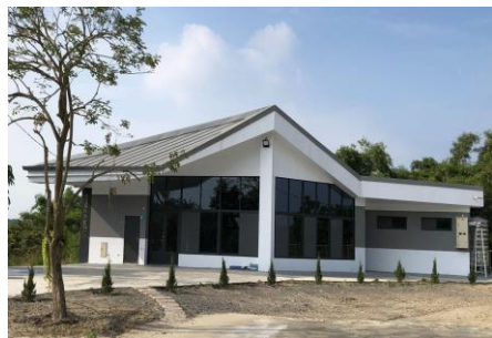
新建-龍崎區土崎里活動中心
