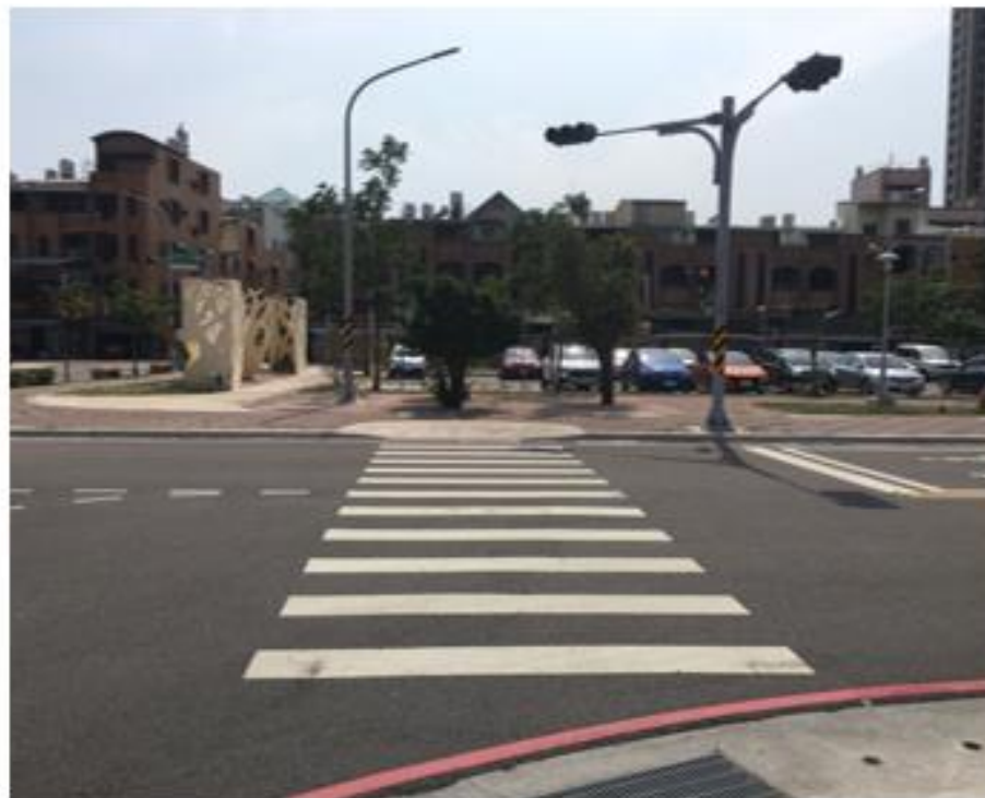
金華新路與府前一街路口 行穿線對齊無障礙斜坡
