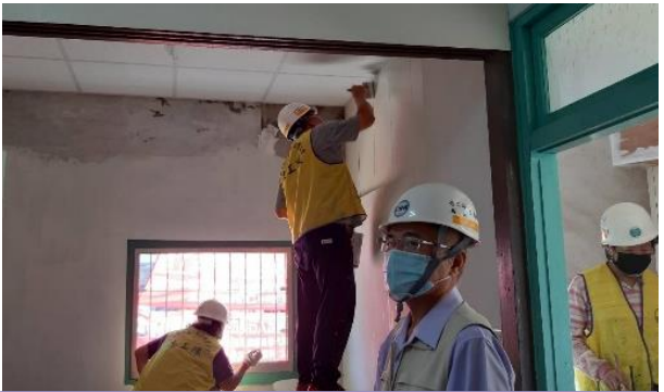
就業關懷發現屋況殘破 進行房屋修繕
