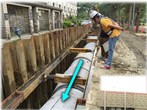
壓力箱涵/管設置
