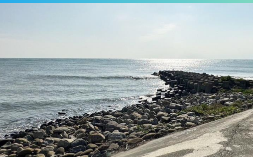
四草大橋北岸堤頂
