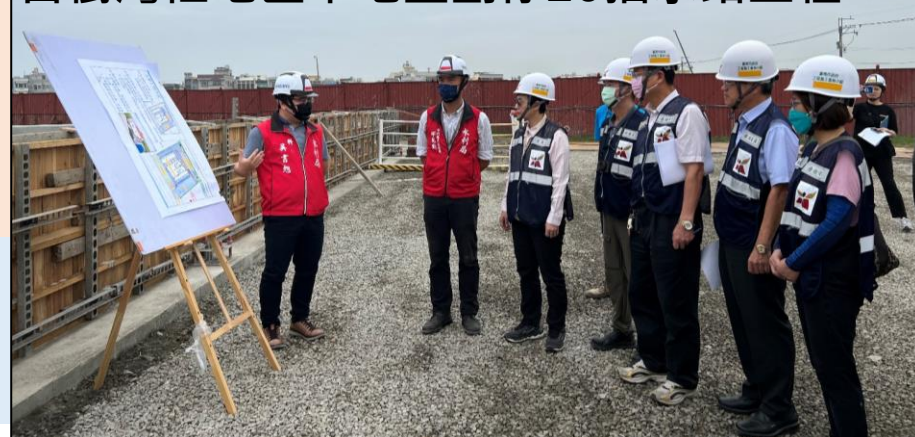
喜樹灣裡地區市地重劃停20抽水站工程
