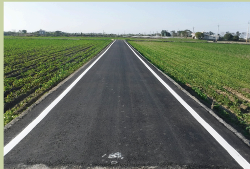
鹽水農地重劃區北路6-4農路改善工程
