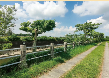
治水路美人樹步道增設太陽能夜間照明設備，打造出夜間燈火長廊
