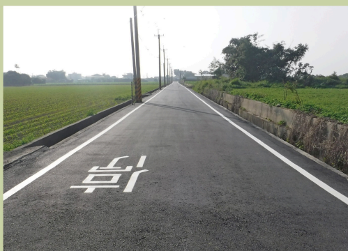
鹽水農地重劃區東路2-6改善工程
